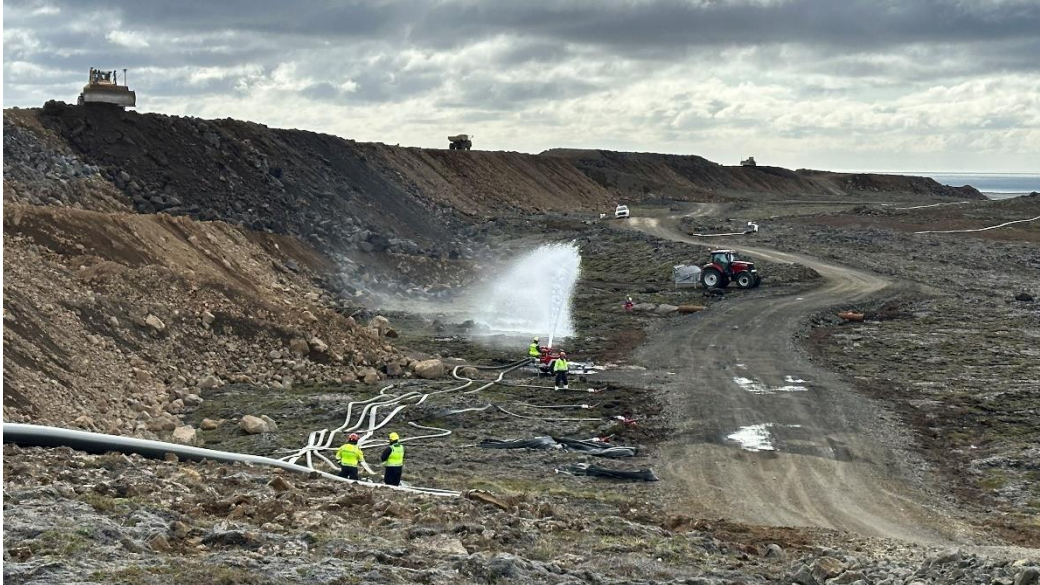
Mynd 5. Bygging varnargarða og prófun á hraunkælingarbúnaði.
